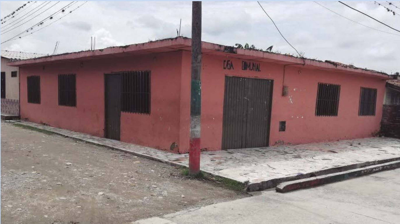
Foto 02. Casa comunal, barrio la Ceiba
